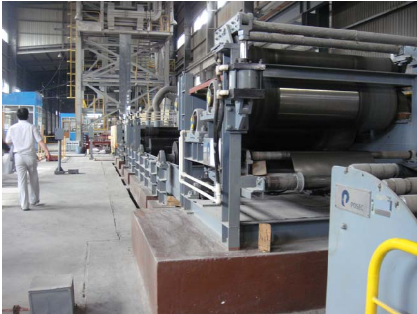
<미얀마 포스코 함석지붕 생산공장>
