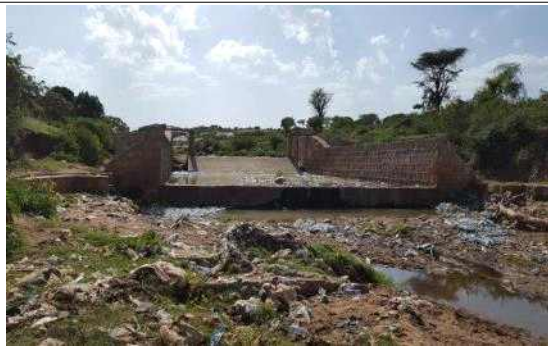
쉐리프하라위 취입보 하류 전경
